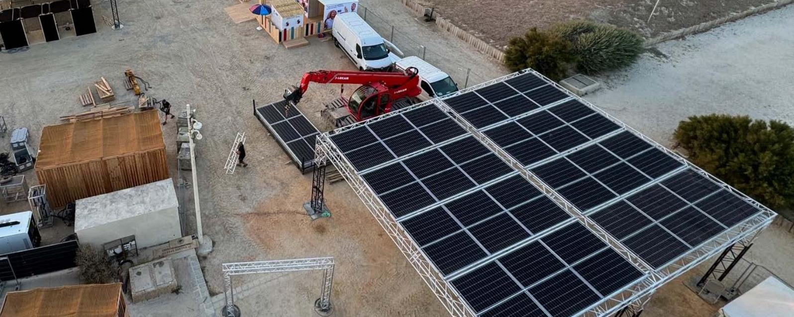
Robustes et puissants, les cadres solaires offrent une solution fiable pour une production énergétique optimale. Conçus pour une installation stable et durable, ils sont empilables jusqu'à 8 unités. Équipés de panneaux solaires fabriqués en France, ils délivrent une puissance de 2,37 kWc, garantissant des performances élevées même dans des conditions exigeantes.
