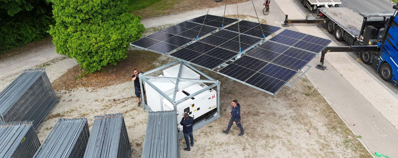
Robustes et puissants, les cadres solaires offrent une solution fiable pour une production énergétique optimale. Conçus pour une installation stable et durable, ils sont adaptables pour des containers 10 pieds. Équipés de panneaux solaires fabriqués en France, ils délivrent une puissance de 9 kWc, garantissant des performances élevées même dans des conditions exigeantes.
